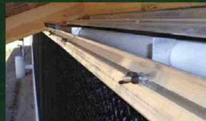
CS sistema: cabezal abierto aluminio
